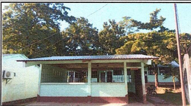
Foto 1: Techo cambiado del aula única.
